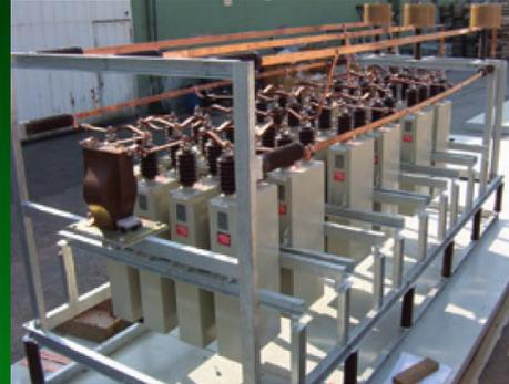
*Banco de compensación del Factor de Potencia de 33kV y 10 MVAR funcionando en una Subestación de la red eléctrica de Irán.*
