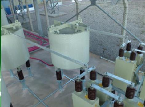
*Sistema de compensación del Factor de Potencia automático en Media Tensión 34.5kV, 2x3 MVAR con 7% filtro de armónicos para planta de Cementos en Turquía*
