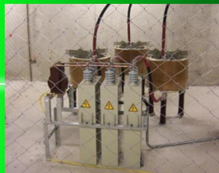
*Banco de Compensación del Factor de Potencia Automático de 4 pasos con 5.41% de filtro de armónicos instalado en una Planta de Cemento en Turquía*
