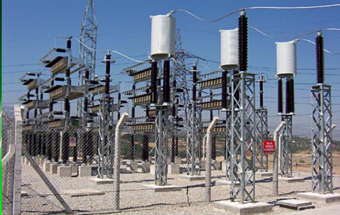
*Sistema de Compensación del Factor de Potencia Exterior en patio de Subestación para redes eléctricas 170kV – 60MVar*
