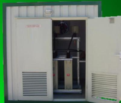
*Banco de Compensación de Factor de Potencia fijo y con envoltorio o quisco metálico instalado en la red eléctrica de Irán.*
